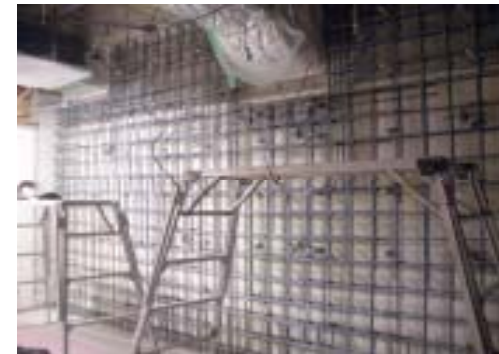
【広島銀行本店耐震改修工事】
