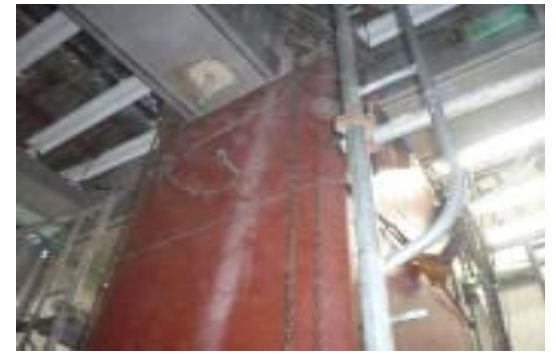
【広島銀行本店耐震改修工事】
