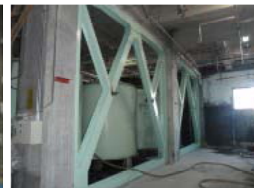
【中国醸造酒蔵棟耐震補強工事】
