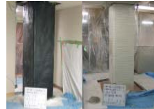
【第一鉄鋼ビル耐震補強工事】
