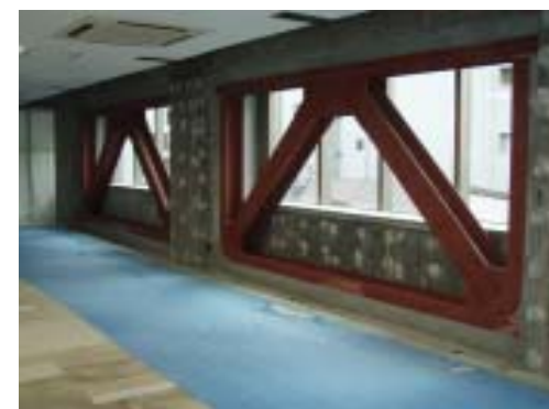
【大阪信愛ビル耐震補強工事】
