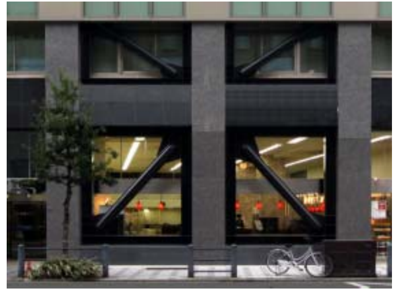
【大阪信愛ビル耐震改修】
