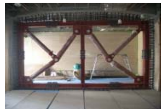
【広島東区庁舎耐震改修工事】
