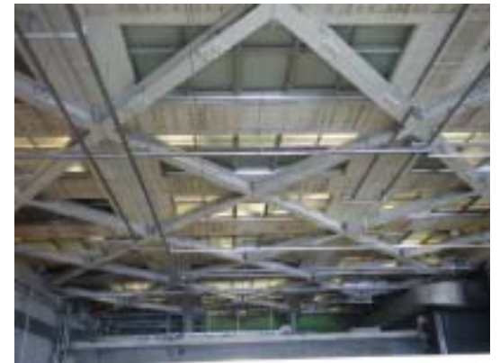
【第一鉄鋼ビル耐震補強工事】
